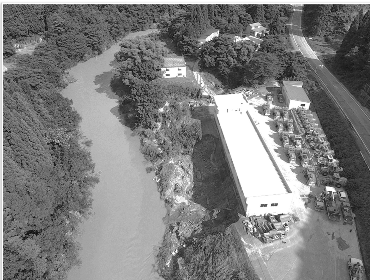
河川の増水で商工業者が被害を受けた除雪センター付近（小国小坂町地内）
